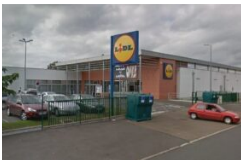
SURVILLE, ALIMENTATION GÉNÉRALE
