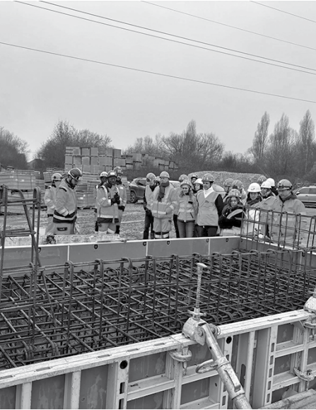
en service en août 2024. Tout vient à point à qui sait attendre !
